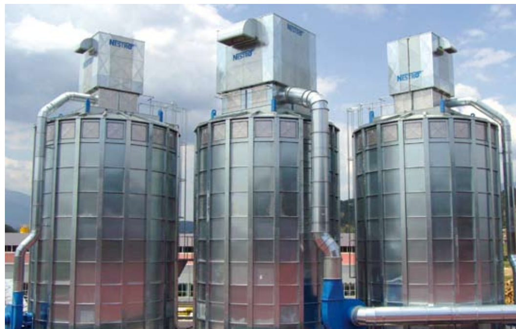
System filtrów stropowych wraz z silosami o pojemności 287 m 3 . fot. Nestro
